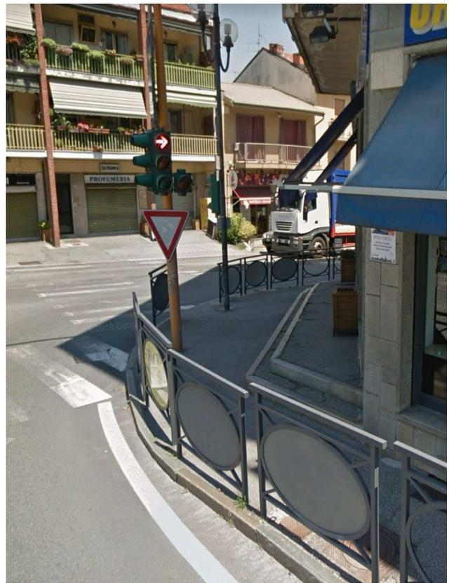
Foto 4 – Barriere metalliche a protezione dei pedoni. Mantenate e adattate alla zona di attraversamenti
